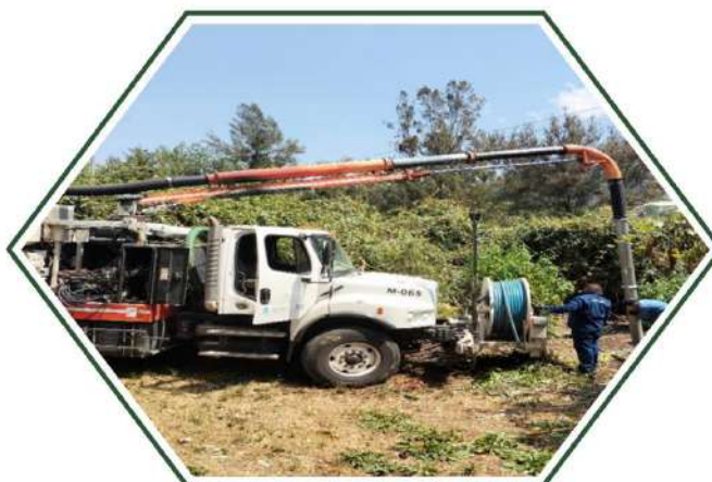
Desazolve de fosas sépticas del CUT.
