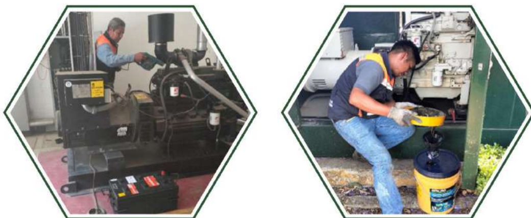
Mantenimiento a las Plantas de Luz del Centro Universitario UEM Tenancingo.
